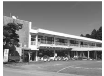
築61年目を迎え老朽化した現庁舎
