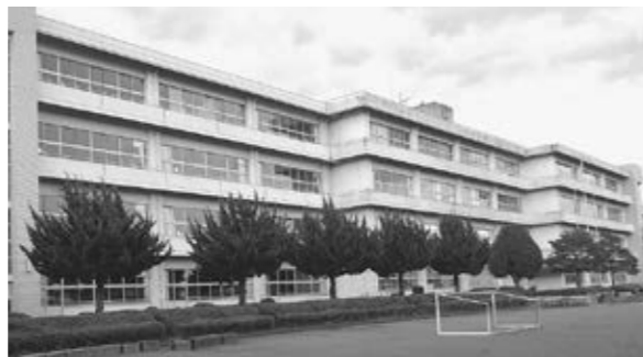
大規模改修で安全な学校環境を (阿中校舎)
