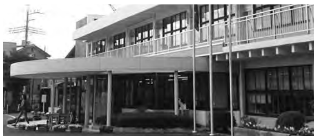
半世紀が経ち老朽化が進んでいる庁舎
