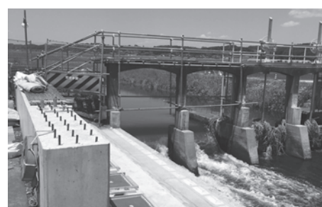
井沼川の橋の架け替え工事
