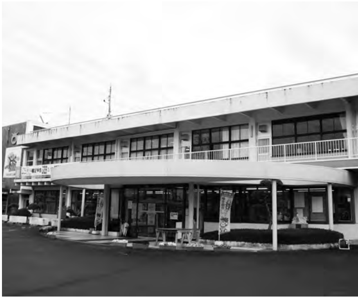
↑間もなく築60年、新庁舎の建設はいつ？
