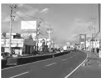
さくら署管内でも事故が多い県道10号線
