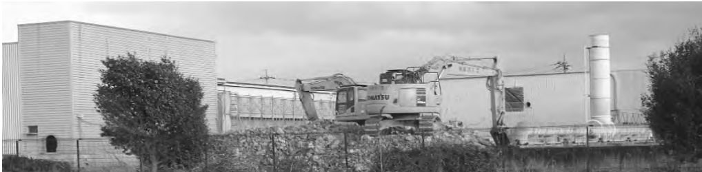
改修工事中の土づくりセンター
