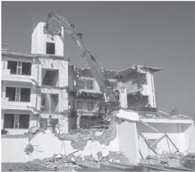
東小学校解体状況
