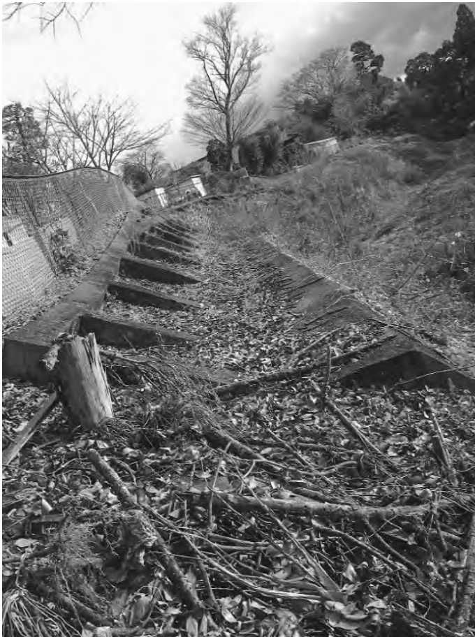
上柏崎地区の地滑り防止区間
