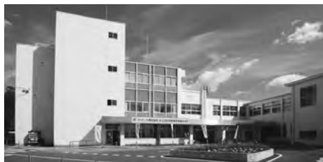
現在の壬生町庁舎 建設中の新庁舎が待ち遠しい
