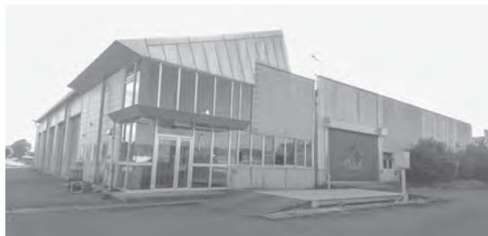
再開を待つ土づくりセンター
