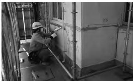
西小外壁工事の施工風景
