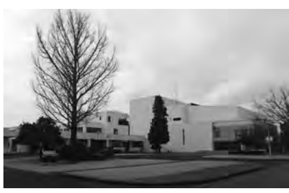
進む公共施設の老朽化
