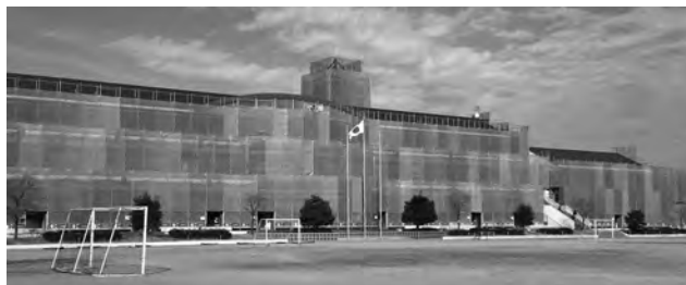
安全安心できる西小学校へアスベスト完全除去
