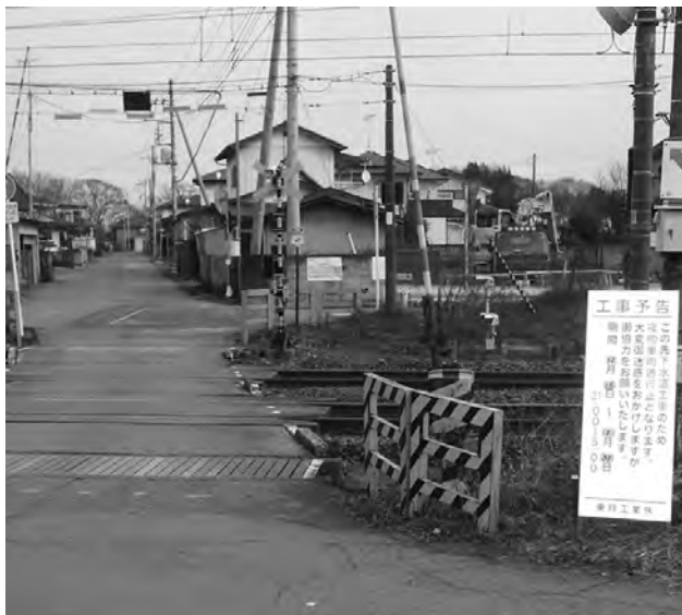
中台地内の大谷踏切 お金がかかってもインフラ整備はしっかり行う
