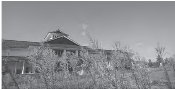
稼働停止中の元気あつぷむら
