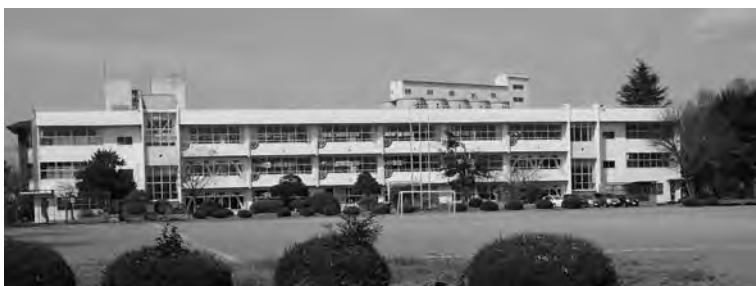
校舎解体が予定されている旧東小学校
