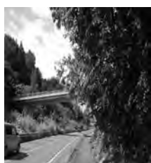
仁井田バイパスの歩道の現状(県道10号)
