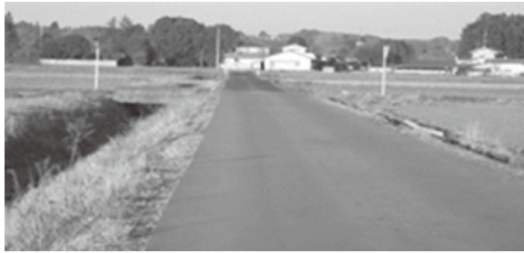
工事が完了した町道87号線（寺渡戸地内）
