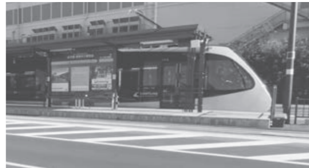
本町から約600mの芳賀・高根沢工業団地停留場
